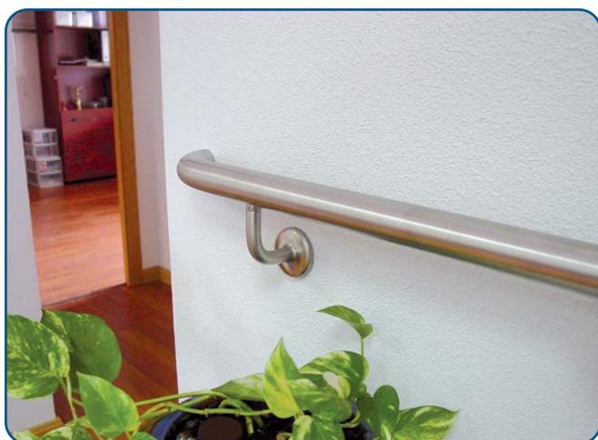
Compuesto de tubo de acero inoxidable AISI 304 de 40 mm. de diámetro y 1.5 mm. de espesor.
